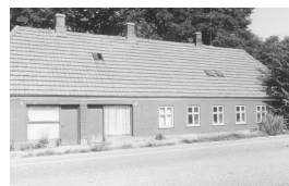
Ejendommen Storegade 308, nu nedrevet. I den ene ende af huset var der kombineret slik-, tobaks-, cykel- og trækoforretning. Foto: Esbjerg Museum, 1982.
