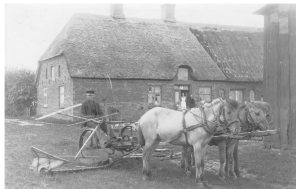
Gården Storegade 280, ca. 1915. Nu Esbjerg Planteskole. Foto: Esbjerg Byhistoriske Arkiv.
